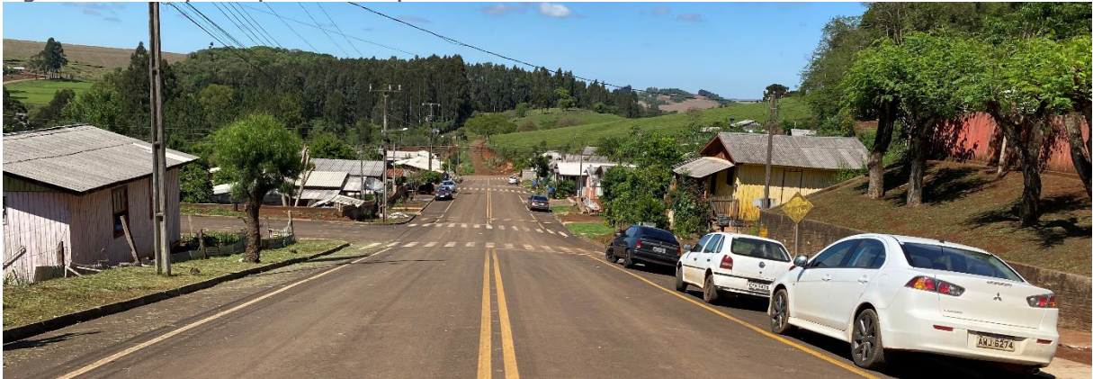
Figura 16 – Exemplo de podas inadequadas na Rua São Sebastião
