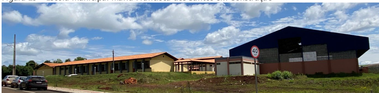
Figura 29 – Escola Municipal Maria Francisca dos Santos em Construção
